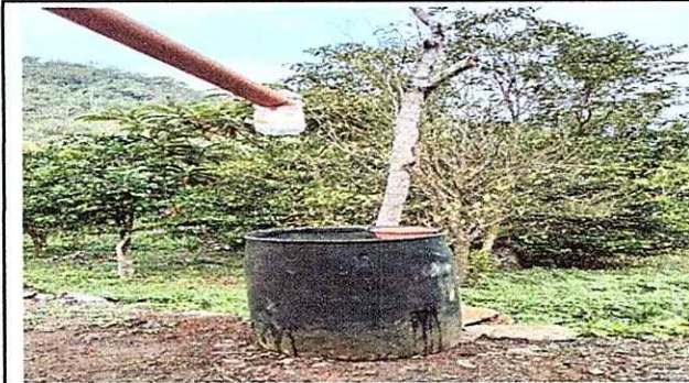
Foto 2: En esta fotografía se observa el Deposito del agua del Establecimiento donde se verifica el deterioro del tonel y por ende el cambio y sustitucion.
