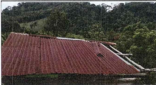
Foto 3: Se puede observar el oxido y el deterioro de las laminas y la falta de ellas en la Cocina del Centro Educativo.
