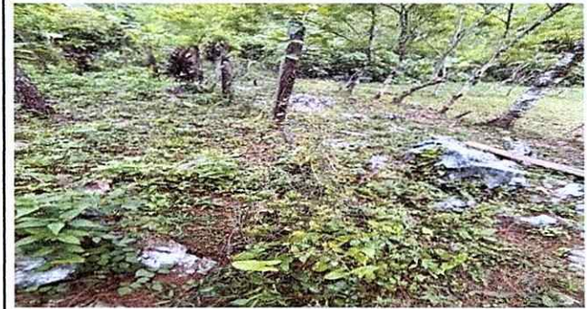
Foto 4: En esta fotografía se puede observar el cerco perimetral de la Escuela en malas condiciones y no demarca el limite del Establecimiento.
